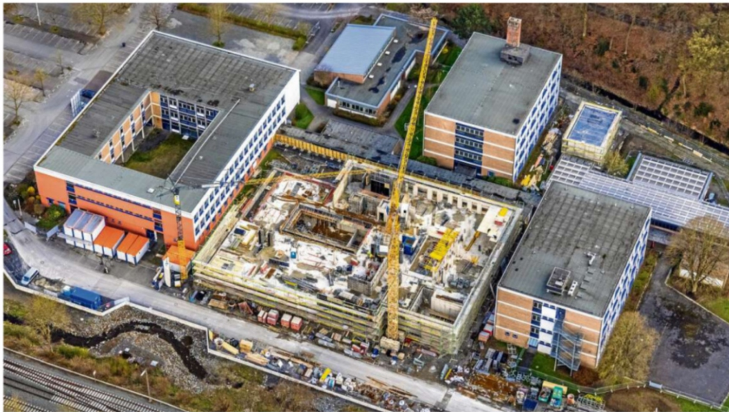
Die Baustelle Berufskolleg Berliner Platz in Hüsten hat unser Luftbild-Experte erst vor wenigen Tagen festgehalten.
